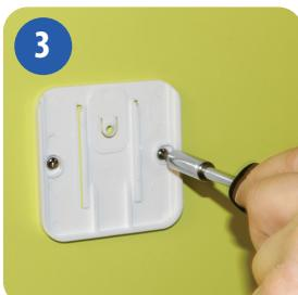
Прикрепите кронштейн для настенного монтажа на стену, используя подходящий крепеж (в комплекте).
