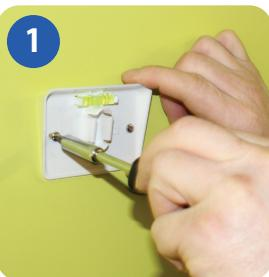
Закрепите док-кронштейн для настенного монтажа на стене, используя крепеж (в комплекте) и встроенный уровень.
