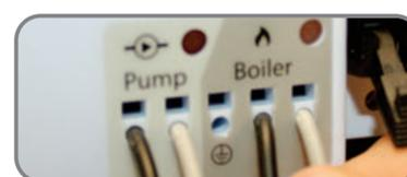
**13** Обеспечьте безопасность подключения проводов благодаря монтажным элементам, поставляемым вместе с центром коммутации.
